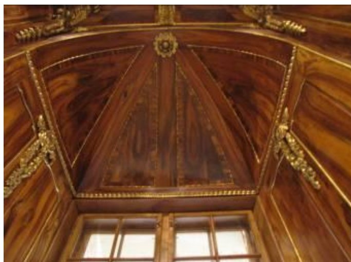
Obr. 4: Historické obložení oken, stav po restaurování
